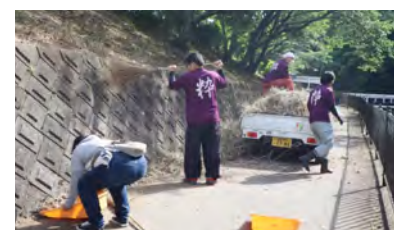
PTA 整備作業
