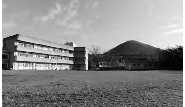
池小学校 校舎全景
